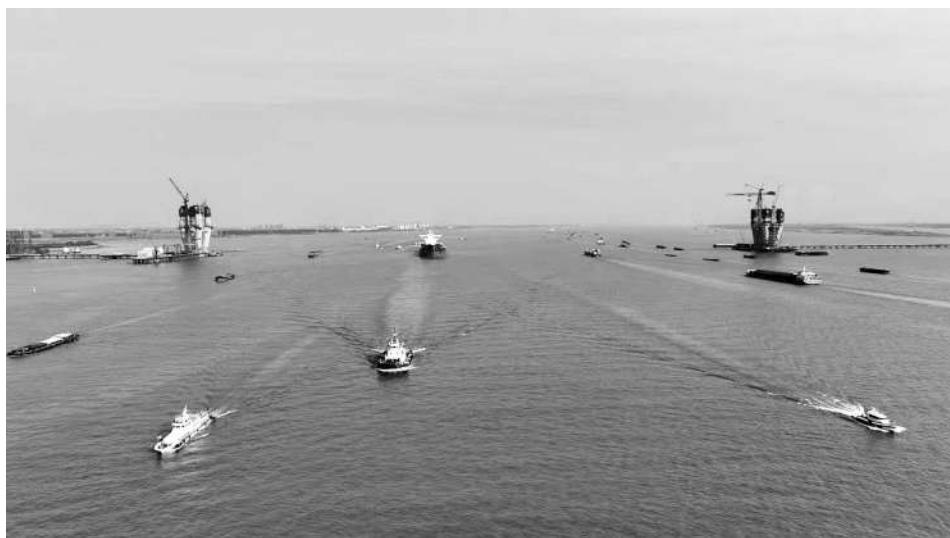
常州海事维护高温环境下大桥施工水域安全。
